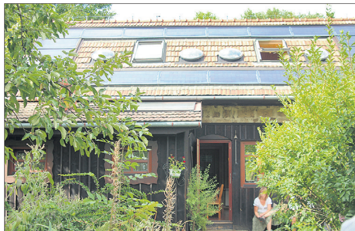
W stryżowskim gospodarstwie nowoczesne technologie spotykają się z tradycyjnymi rozwiązaniami. Dlatego wybudowany z gliny i słomy budynek ogrzewany jest energią słoneczną
